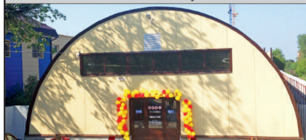
СКЛАДСКИЕ И ПРОИЗВОДСТВЕННЫЕ ПОМЕЩЕНИЯ
